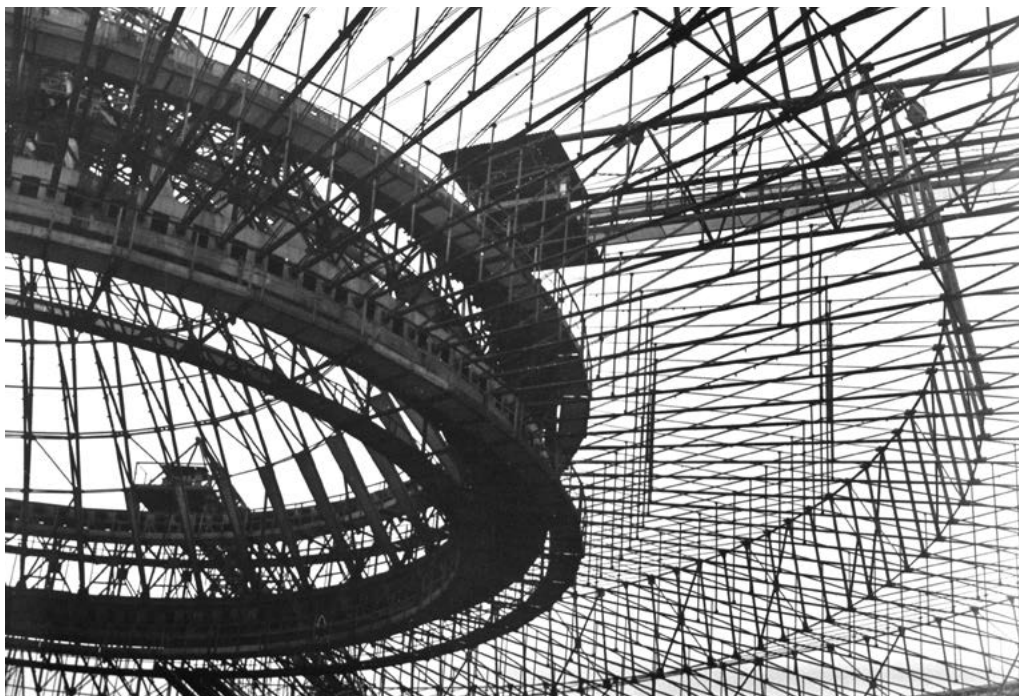
KONSTRUKCJA DACHU SPODKA, FOT. MIECZYSLAW MIGON
