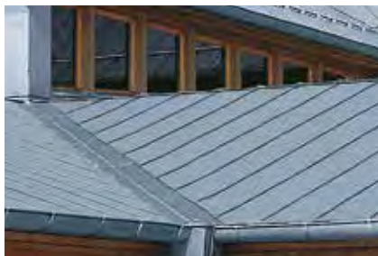
Kosz z rąbką pojedynczym oraz pasem włutowanym
