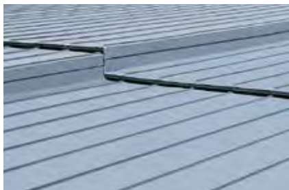
Połączenie poprzeczne: uskok z rąbkem leżącym
