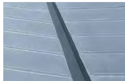
Rynna wewnętrzna skrzynkowa z wyklejaną rynną zabezpieczającą
