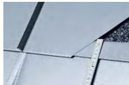
Połączenie poprzeczne: rąbek pojedynczy
