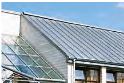
Kalenica dachu jednospadowego na listwę
