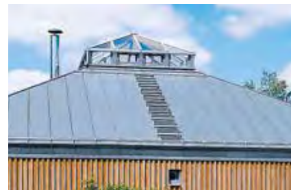
Uchwyty dla stopni lub rusztów komunikacji dachowej
