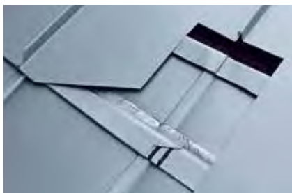
Optymalne wykonanie: dodatkowy pas włutowany
