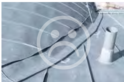
Kosz z bocznymi połączeniami na rąbek
