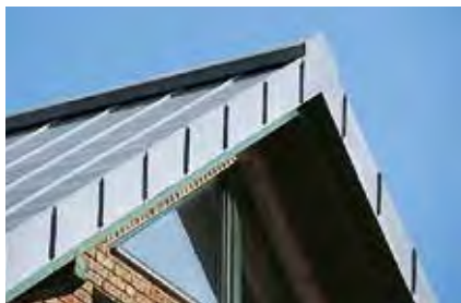
Kalenica dachu dwuspadowego
